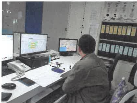
รูปที่ 2-7 การควบคุมท่อส่งน้ำมันด้วยระบบ Supervisory Control and Data Acquisition (SCADA)
