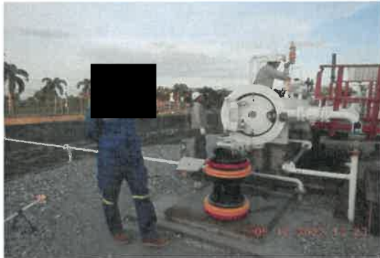
รูปที่ 2-2 การทำความสะอาดท่อส่งน้ำมันด้วย Cleaning Pig
