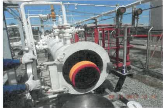
รูปที่ 2-2 การทำความสะอาดท่อส่งน้ำมันด้วย Cleaning Pig
